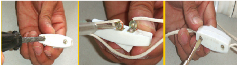
شکل (۲-۲۴): د سيار څراغ د سيم په امتداد کې د سوپچ د نصبولو مرحلې
